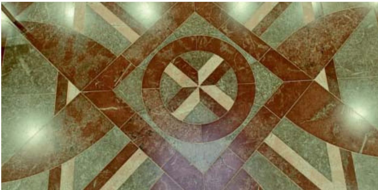
Fig 4.61 Mönstergolv med kalksten i två kulörer och två ytbearbetningar.
