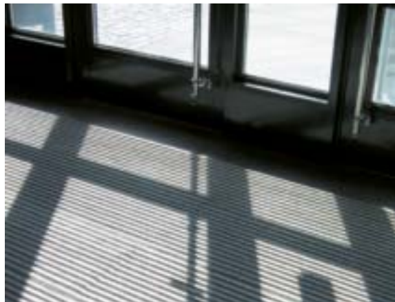
Fig 4.47 Granit med frästa spår som avtorkningsyta. Elegant och effektivt.
