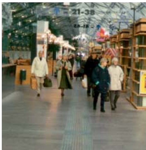
Fig 4.48 Plattor med avvikande kulör och med frästa spår inlagda för att vägleda synsvaga är samtidigt ett dekorativt inslag i miljön.
