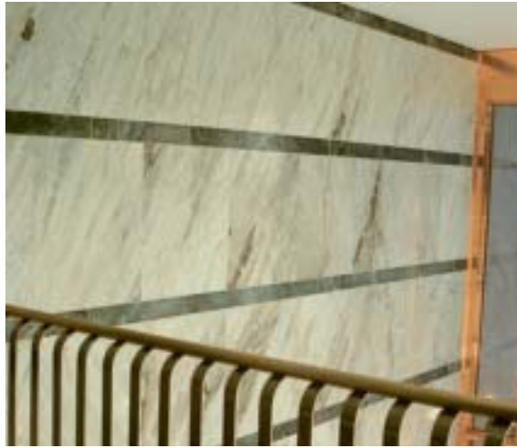
Fig 6.2 Exempel på väggmönster.
