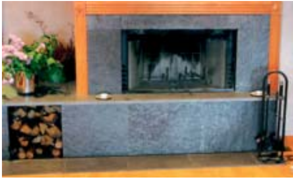
Fig 9.3 Inramning av skiffer med klovtyta.
