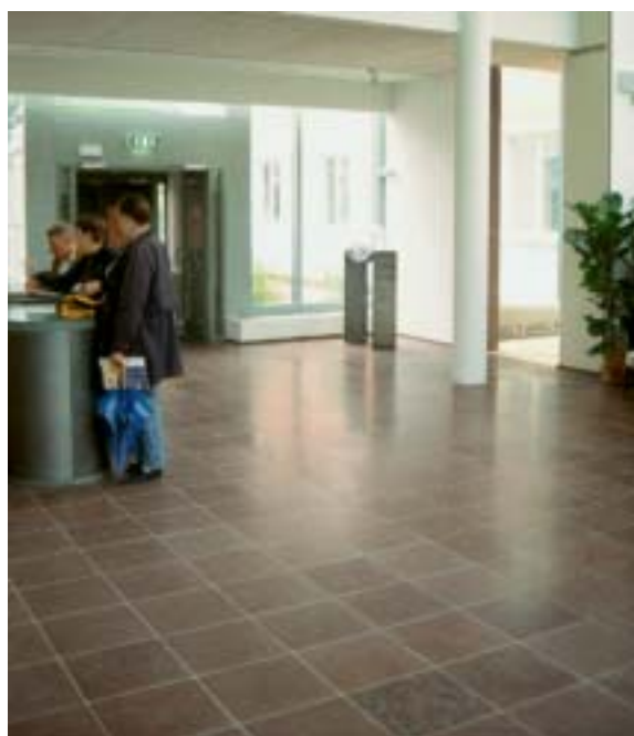
Fig 4.22 Traditionellt, finslipat kalkstengolv med kvadratiska plattor.
