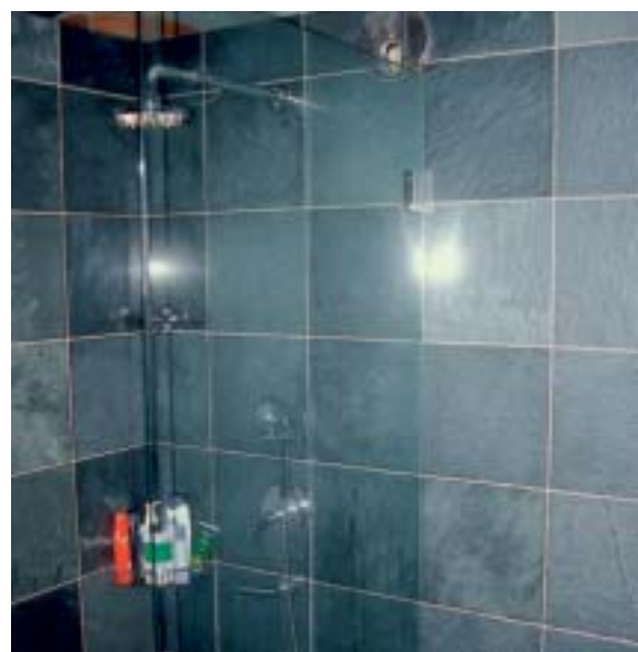
Fig 7.3. Polerade plattor av skiffer på vägg i duschrum.
