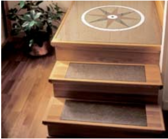
Fig 5.28 Trätrappa med kalksten infälld.
