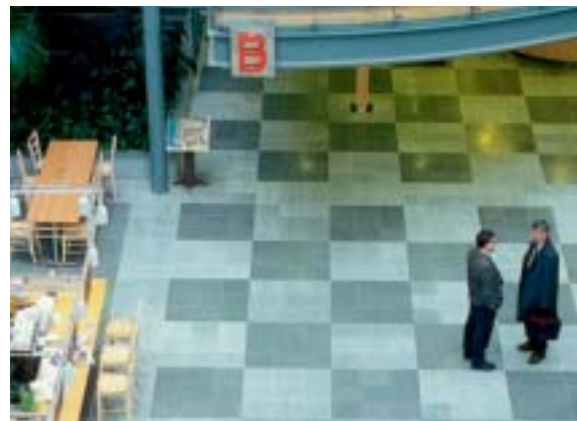
Fig 4.4 Variationen i kulör mellan hyvlad och finslipad yta ger monstereffekt i detta ruttmönster.
